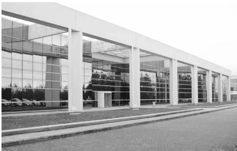
Bâtiment de Merck Millipore à Saint-Quentin-en-Yvelines ©Merck Millipore
